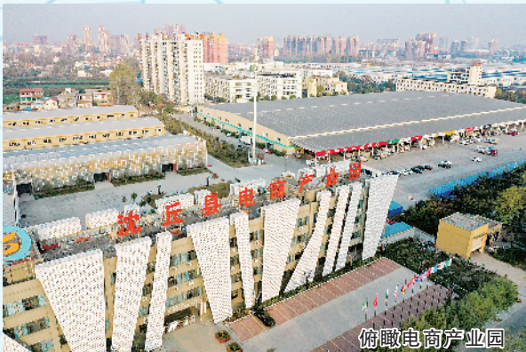
俯瞰电商产业园
