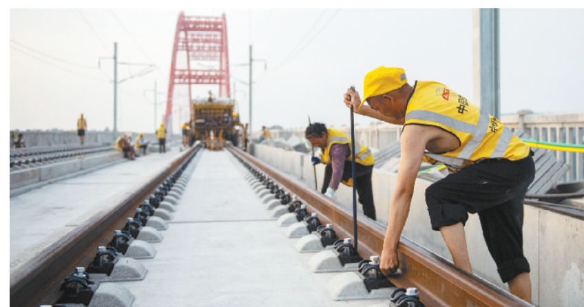
常益长铁路铺轨顺利过水特大桥 7月18日,工人在常益长铁路水特大桥进行无砟轨道铺设作业。 当日,轨道铺设顺利过常(德)益(阳)长(沙)铁路控制性工程水特大桥,为常益长铁路早日通车运营奠定基础。 新华社记者 陈思汗 摄
