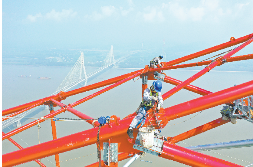
白鹤滩至浙江特高压长江大跨越输电塔封顶
