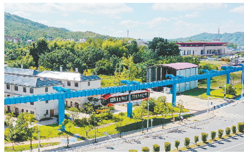
国内首条稀土永磁磁浮轨道交通工程试验线竣工
