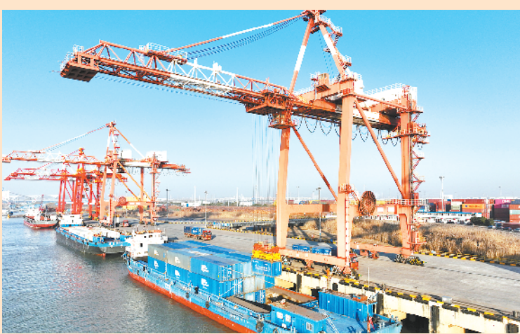
1月28日,货轮在江苏省扬州港集装箱码头进行集装箱装卸作业。当日是春节假期结束后的开工第一天,各地企业铆足干劲、一派繁忙,奋力实现“开门红”。新华社发
