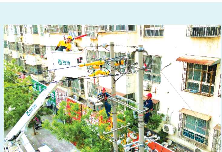
4月14日,国网西华县供电公司带电作业班员工在10千伏板厂线与10千伏西工线联络处成功开展带电作业,消除线路安全隐患,确保群众用电安全。 记者 张猛 通讯员 徐浩然 摄
