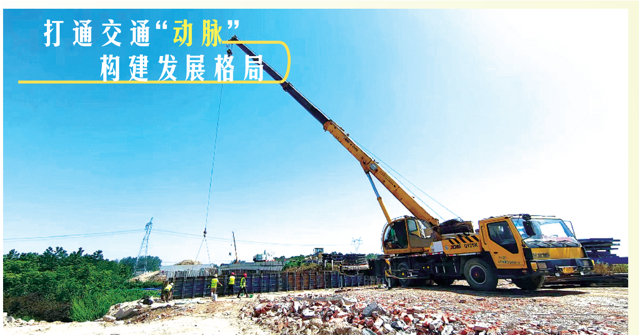
6月9日,中州大道北延工程施工现场,数十台大型机械正在有序施工作业。该项目的实施,对促进西华与周口中心城区高效连接、带动沿线城镇建设具有十分重要的意义。 记者张猛 摄
