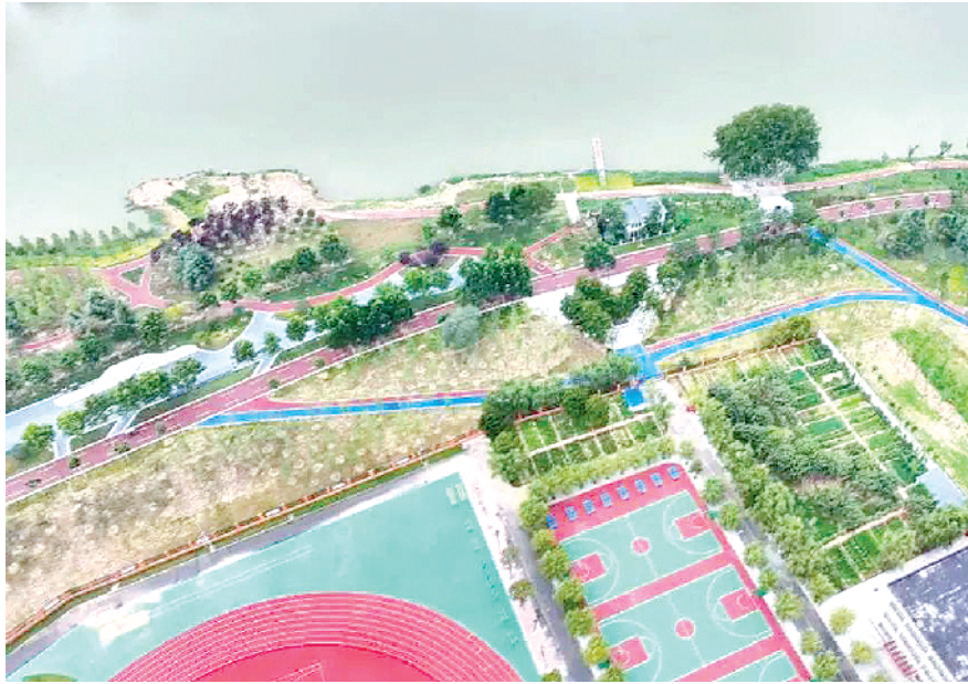
周口滨河公园(三期)北岸新景俯瞰
