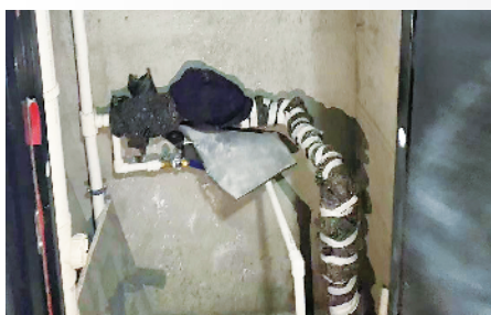
楼道内堆放杂物。
