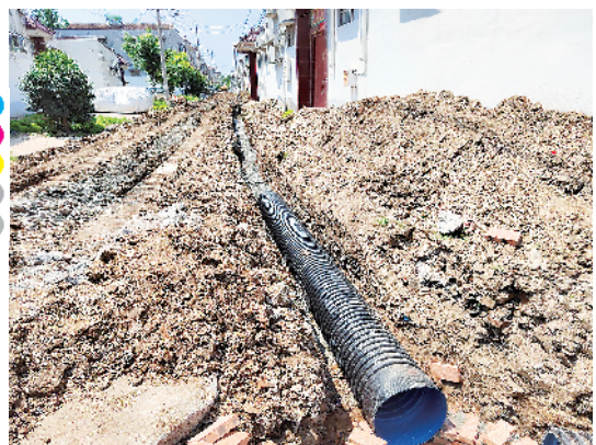
固墙镇赵吉村挖建下水道解决排水问题。
